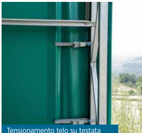
Tensionamento telo su testata Head tensioning cover
