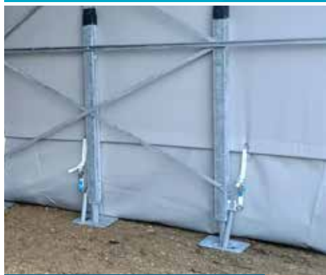
Ancoraggio al terreno Ground fastening
