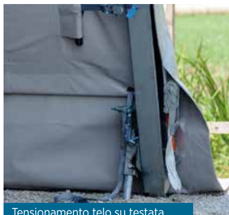
Tensionamento telo su testata Head tensioning cover
