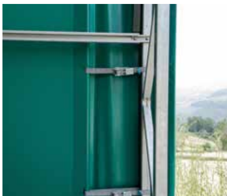
Tensionamento telo su testata Head tensioning cover
