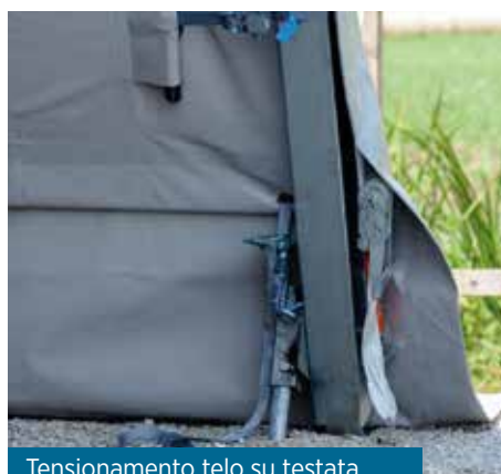
Tensionamento telo su testata Head tensioning cover
