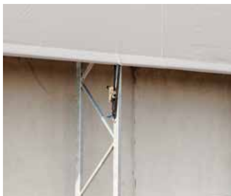
Tensionamento telo laterale Side tensioning cover
