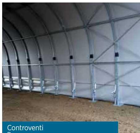
Ancoraggio su platea Anchorage on slab
