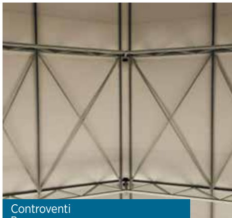
Struttura a traliccio Trellis structure
