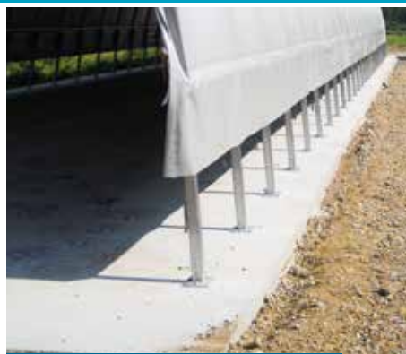
Ancoraggio su platea Anchorage on slab
