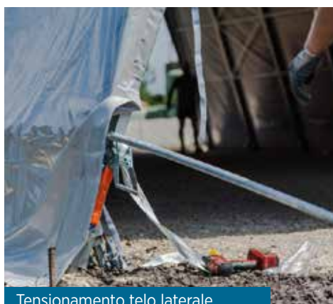
Tensionamento telo laterale Side tensioning cover
