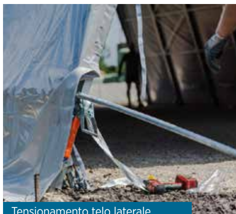
Tensionamento telo laterale Side tensioning cover
