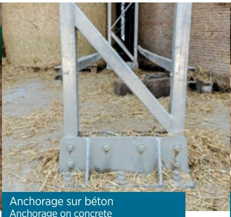
Ancrage sur béton
