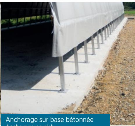
Ancrage sur base bétonnée
