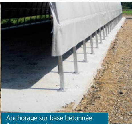
Ancrage sur base bétonnée
