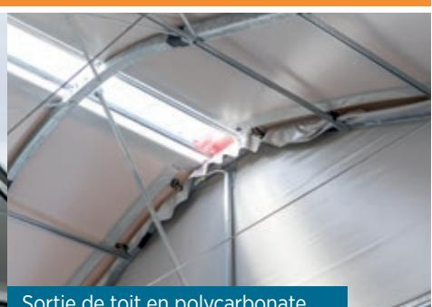
Sortie de toit en polycarbonate
