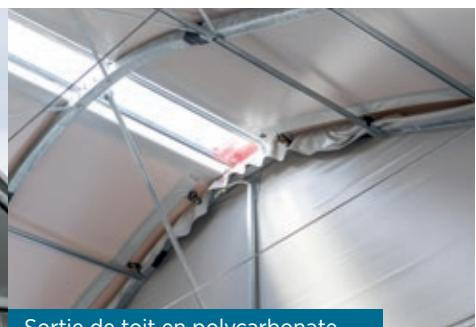
Sortie de toit en polycarbonate
