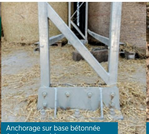
Ancrage sur base bétonnée
