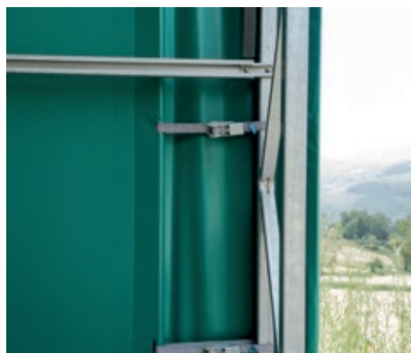
Tension des bâche avant Head tensioning cover
