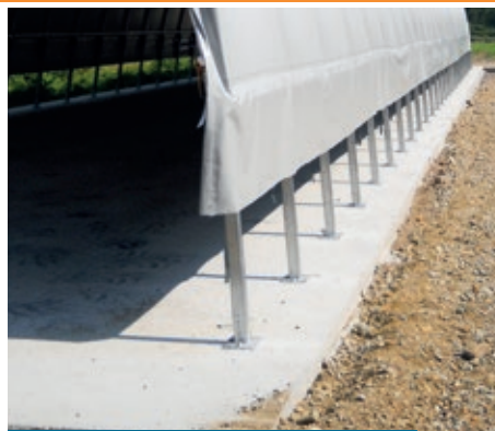
Anchorage sur base bétonnée Anchorage on slab
