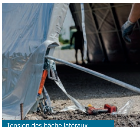
Tension des bâche latéraux Side tensioning cover
