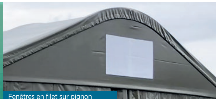
Fenêtres en filet sur pignon Net side window on gable
