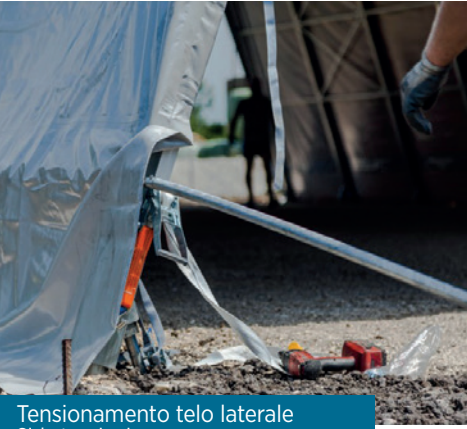
Tirante di rinforzo Reinforcing tie rod
